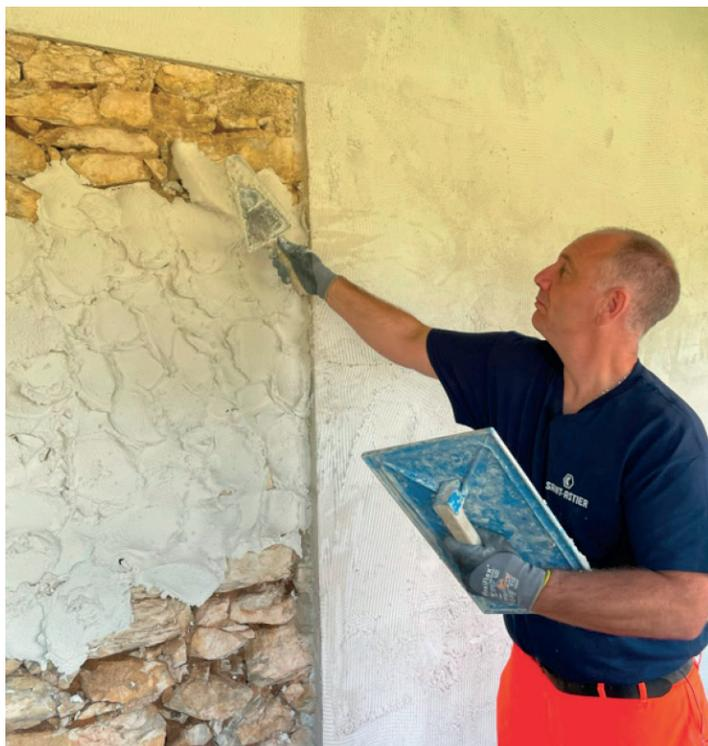
Tenue et aspect du sous-enduit NOVASKIN® Thermo Plus.
