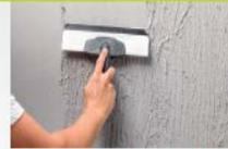
**2 - ÉGALISER.** Répartir la matière fraîche déposée avec le lisseur à lame crantée.
