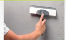
**3 - SURFACER.** Lisser dans le frais avec le lisseur à lame Liss souple, tout en laissant quelques cilles, coups de lames, vagueslettes.
