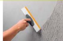
**5 - RATISSER** dans le frais avec le lisseur à lame Liss dure avec un angle fermé, les motifs créés en 1<sup>re</sup> passe se révéleront ainsi. Pour un décor plus nuancé et onix au toucher, repasser délicatement sur l'enduit le lisseur à lame Liss dure afin de resserrer le grain.
