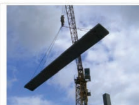
PLANCHER BETON - PREDALLES La prédalle, plaque de béton préfabriquée sert à former la partie inférieure d'un plancher, elle [...] Fabricant : BCB EXPLOITATION
