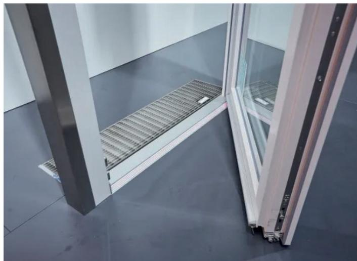
Seuil à séparation thermique Roto Eifel TB avec ouverture vers l'extérieur
