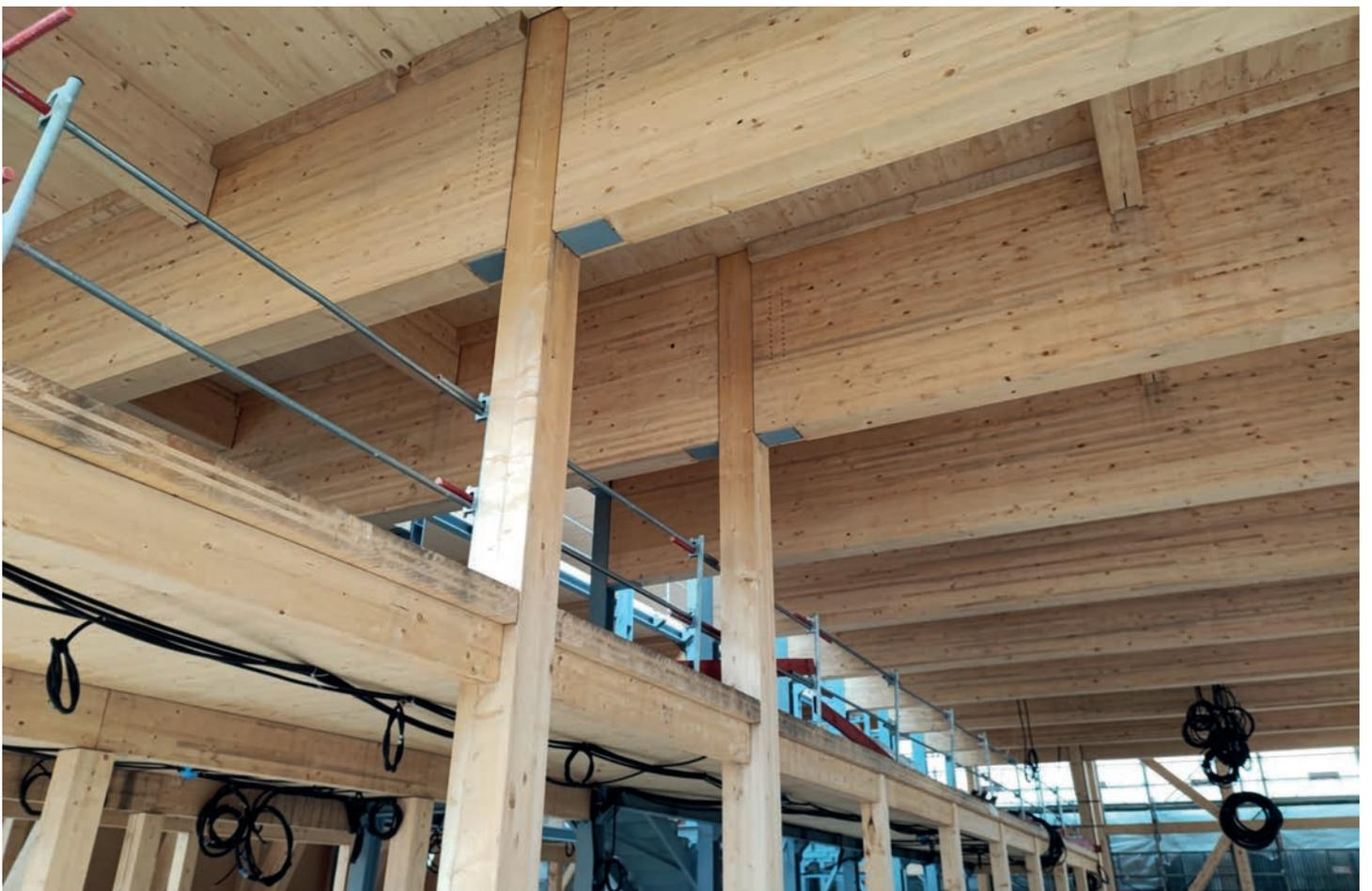
En partie haute du premier niveau, des poutres en lamellé-collé de 1,8 m de hauteur contribuent à reprendre les efforts des 7 niveaux au-dessus. Leur hygrométrie a été contrôlée avant leur pose, ainsi que celle de tous les ouvrages en bois qui seront encapsulés dans le cadre de la protection anti-incendie de la structure. ©PP
