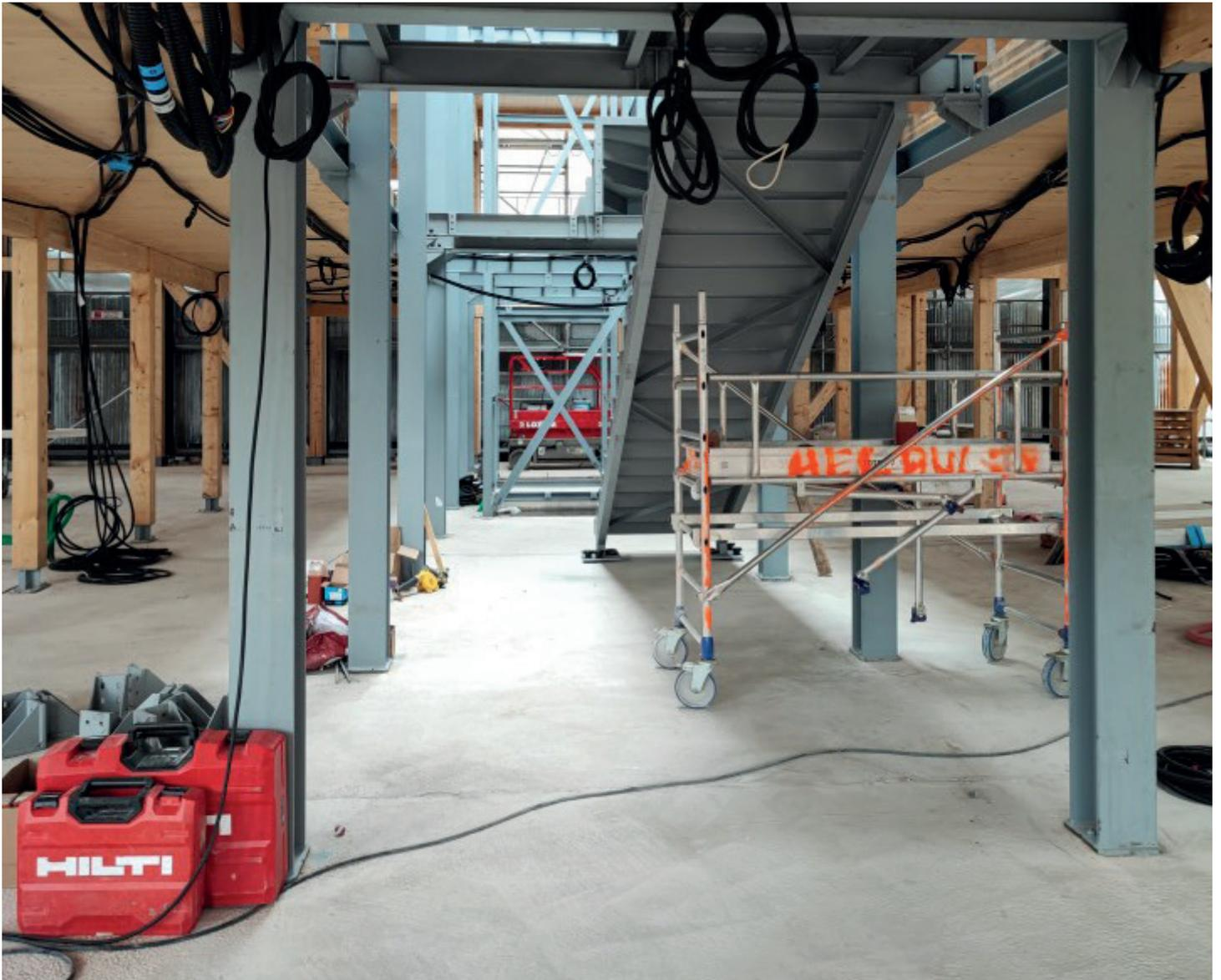
du périphérique en dessous, des couches résilientes sont posées entre le béton de la dalle et les structures métalliques, entre la dalle et l'accrochage des poteaux bois, entre la dalle et les murs en CLT (Cross-Laminated Timber, des planches croisées et collées) et, à chaque étage, entre les planchers en CLT et leurs supports, ainsi qu'entre les planchers CLT et la structure métallique au centre du bâtiment. ©PP
