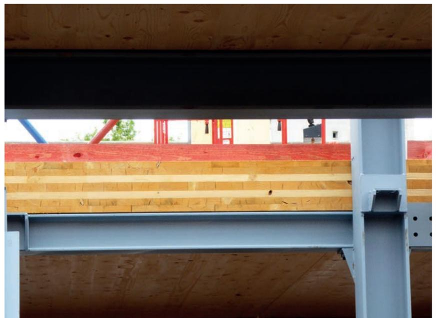
des niveaux supplémentaires. ©PP Les planchers font appel à des panneaux de CLT à 7 plis, complétés par des chapes sèches. ©PP
