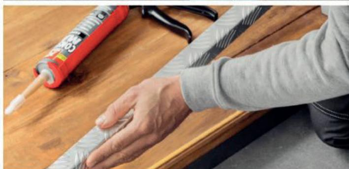
Avec sa prise de 30 minutes, elle permet une exécution rapide et soignée des chantiers d'autant que la colle ne rétrécit pas et supporte des températures de -40 à 120 °C. Sa grande élasticité répond aisément aux mouvements naturels de flexions de matériaux.
