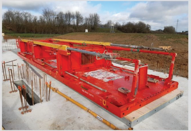
Montage à plat d'une banche pour voile
